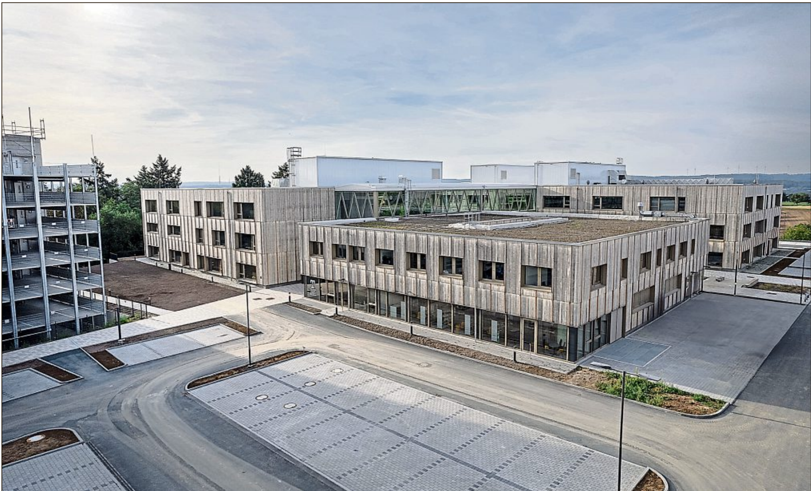
Der Neubaukomplex besteht aus vier Baukörpern, verbunden über eine gläserne Pausenhalle.
